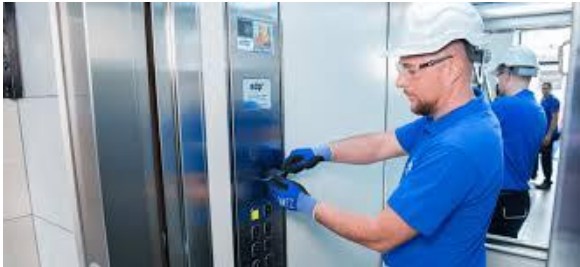
Ilustración 1: Mantenimiento de Ascensor con EPP
